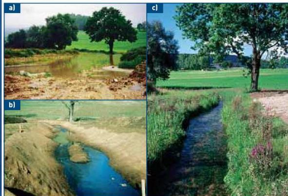
Figure 9 : Remise à ciel ouvert (décorrection) d'un petit cours d'eau dans le Jura suisse (la Golatte) avec cependant une emprise limitée : a) et b) lors des terrassements ; c) 6 mois après les travaux. ≈
